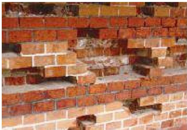
Universität Krakau: Derartig beschädigte Ziegelfassaden wurden mit dem Ziegelrestauriersystem wieder hergestellt. (Bild 1, *epasit*)
