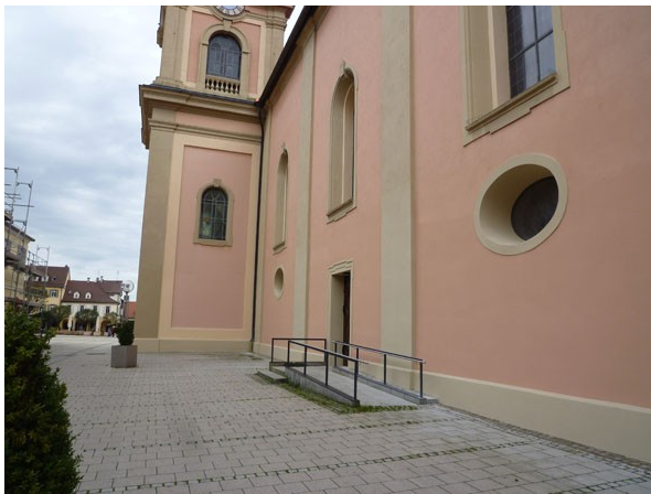
Bild 9: Der Sanierputz ist fertig aufgetragen
