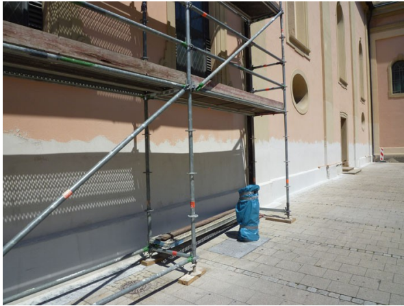
Bild 9: Der Sanierputz ist fertig aufgetragen
