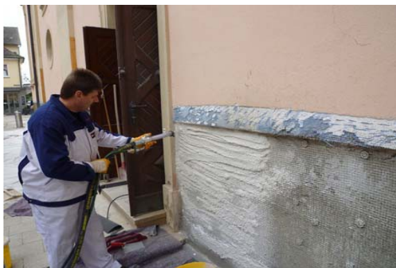
Bild 7: Sanierputzauftrag
