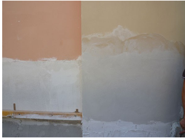
Bild 10: Die Oberfläche wird mit feiner Sanierschlämme überschlämmt, bevor der Anstrich erfolgt
