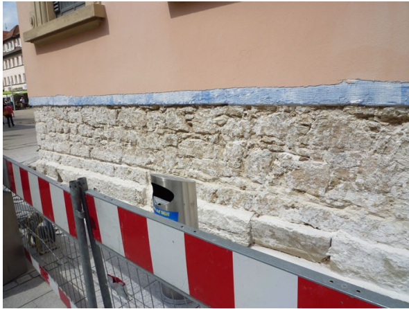
Bild 3: Das Mauerwerk ist freigelegt und gereinigt
