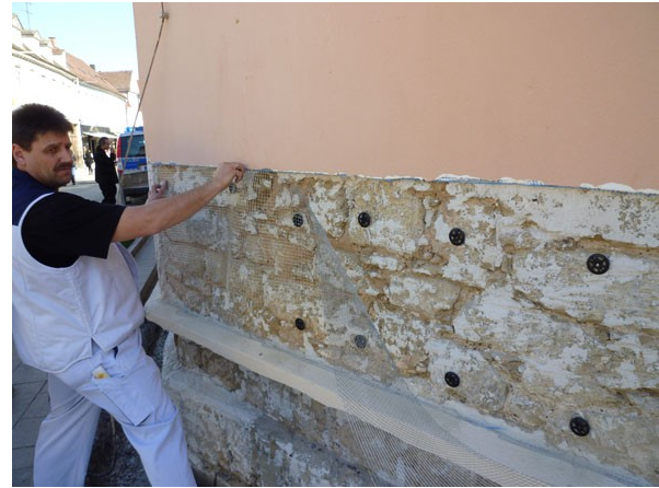
Bild 4: Der Putzträger wird angebracht
