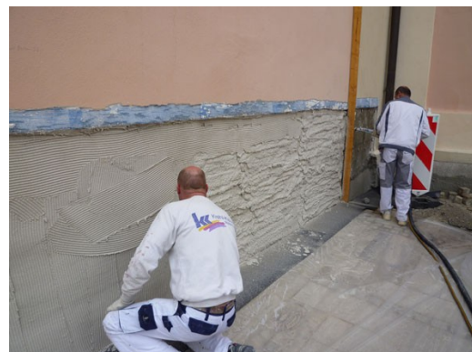
Bild 8: Der gesamte Sockelbereich wird mit Sanierputz überzogen
