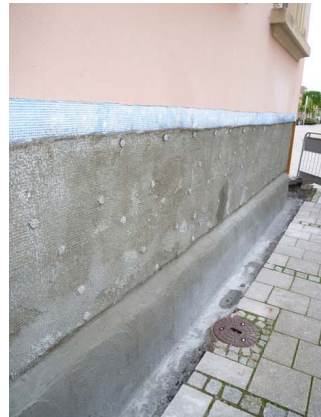
Bild 4: Der Putzträger wird angebracht
