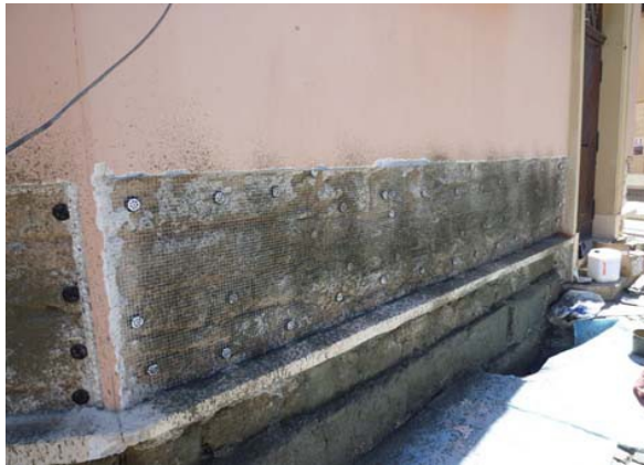
Bild 3: Das Mauerwerk ist freigelegt und gereinigt
