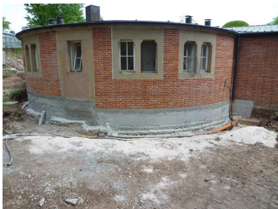
„Sockel verputzt“ Bildquelle: epasit
