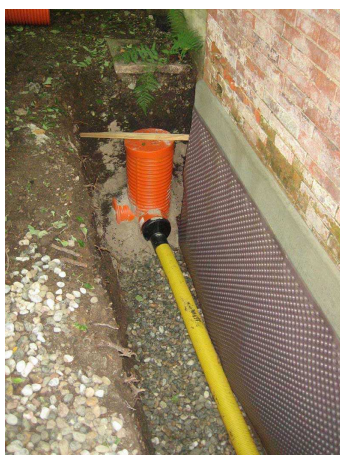
„DrainageSpülkasten“ Bildquelle: epasit
