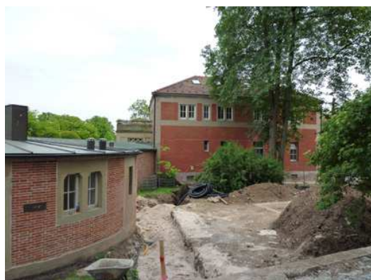
„Baustelle“ Bildquelle: epasit
