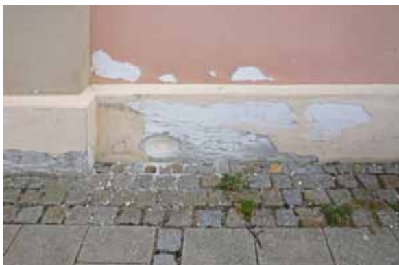
Rechts: Der Haftspritzbewurf ist aufgebracht
