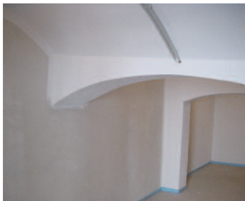
8 Durch Maßnahmen von innen sind wieder nutzbare Kellerräume entstanden. (Fotos: Dr. Kollmann/Epasit)
